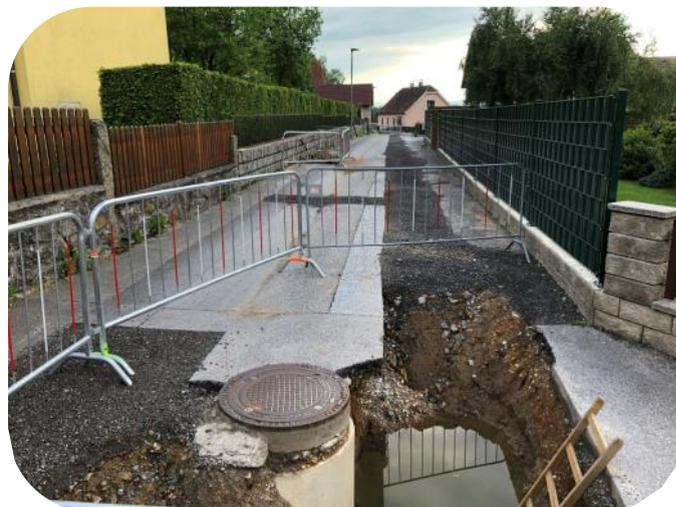
Derzeit im Bau sind die Wasser-, Gas- und teilweise auch eine neue verstärkte Stromleitung in Katzenbergen. Auch diese Gasse stellt, wie die Waldgasse, eine große Herausforderung an die Mitarbeiter der Firma Leyrer & Graf und unseren Bauhof dar, da diese Gasse sehr eng und noch dazu eine Sackgasse ist. Die Arbeiten gehen aber gut voran und werden bald abgeschlossen sein.
